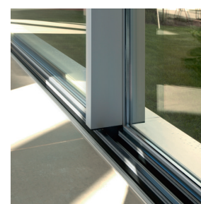
Detalhe do nó central de cruzamento das folhas com soleira embutida no pavimento interior e exterior. A profundidade do montante da folha depende da pressão que é necessário suportar para que o vidro não crie flecha superior ao permitido.
